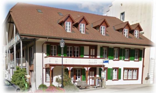
Beratungsstelle Huttwil Foto: Google Street View Urheberrecht: Berner Zeitung
